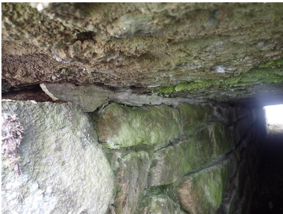
Foto 3: Místy vypadané spárování mezi kameny
