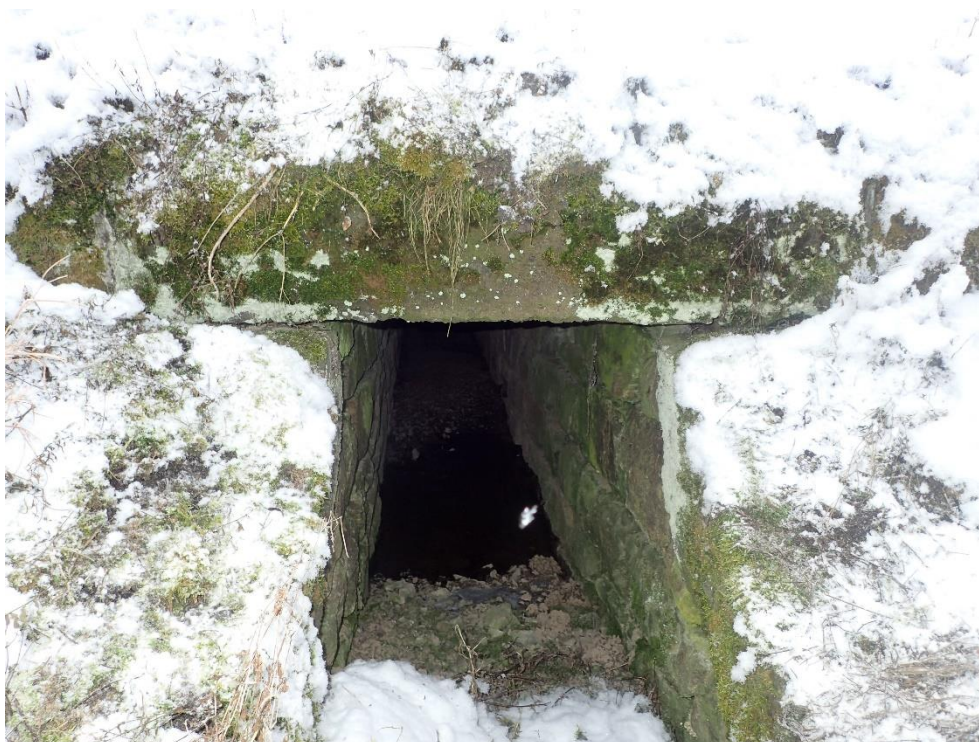
Foto 2: Pohled na vtok propustku
